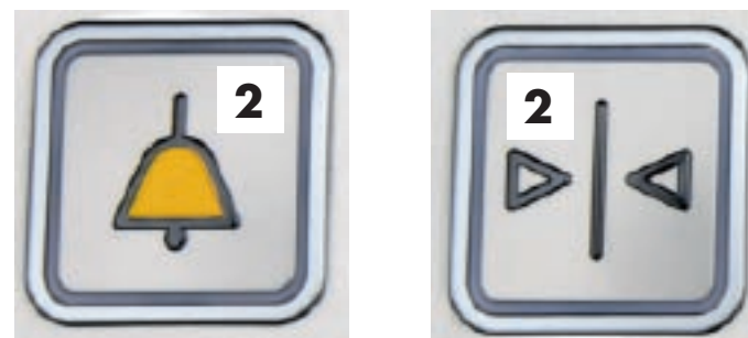
(2) Symbole: zum Hintergrund kontrastierendes Relief mit 15 mm – 40 mm Zeichenhöhe (Reliefhöhe: min. 0,8 mm)
