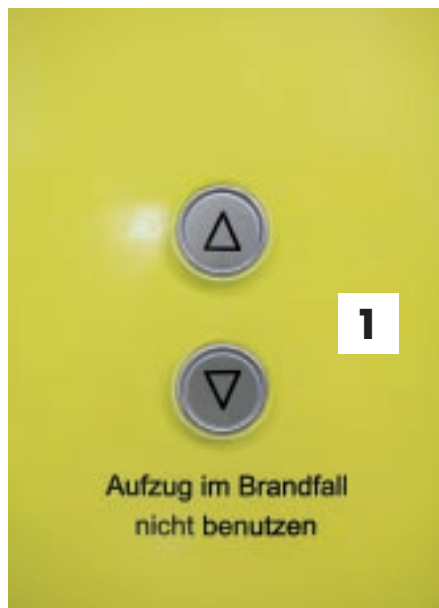
(1) Deckplatte des Bedientableaus: Farbkontrast zu ihrer Umgebung
