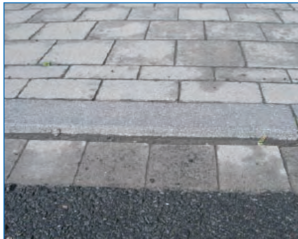
Abbildung 55: Bord mit 10 mm Rundung 111
