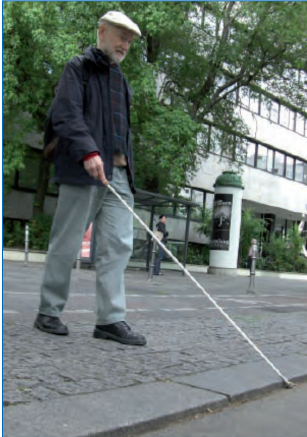
Abbildung 54: Blinder Fußgänger mit Langstock an einem 3 cm hohen Bord
