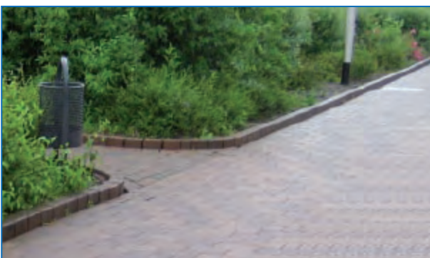
Abbildung 179: Sehr gut als Tastkante nutzbare Einfassung einer Grünanlage
