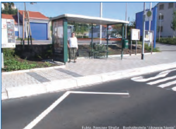
Abbildung 136: Bordsteinformen und -gestaltung an Bushaltestellen 361
