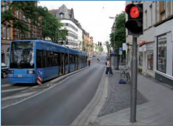
Abbildung 140: Straßenbahnhaltestelle in Mittellage mit Sicherung des Einstiegsbereiches durch eine LSA („Zeitinsel“) und Fahrbahnanhebung (Kassel)
