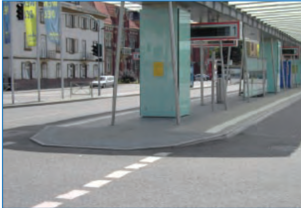
Abbildung 109: Regionaler ZOB mit Inselhaltestellen, elektronischer dynamischer Anzeige, erhöhte Borde sowie Blindenleitsystem (St. Wendel/Saar)
