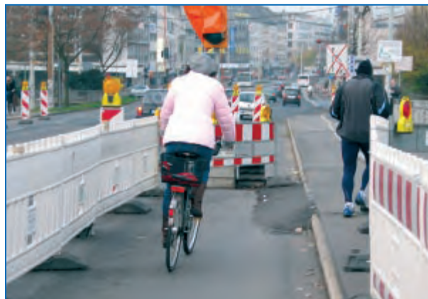
Abbildung 90: Baustelle mit Sicherung durch Absperrschranken und Bitumenkeil am Übergang zur Baustelle 222
