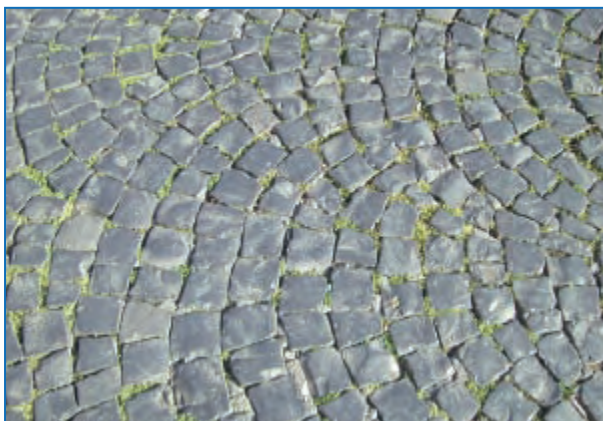
Abbildung 11: Ungeeignetes, unebenes Natursteinkleinpflaster (Basalt), schwer befahrbar insbesondere wegen der Fugenbreite von bis zu 20 mm und bei Nässe glatt
