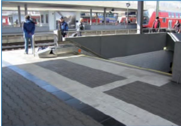
Abbildung 152: Auffangstreifen und Aufmerksamkeitsfeld vor einer Treppe an einem Bahnsteig (Hauptbahnhof Mannheim)
