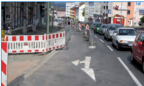
Abbildung 88: ... und die (teilweise) Umsetzung an einer Baustelle (Kassel)
