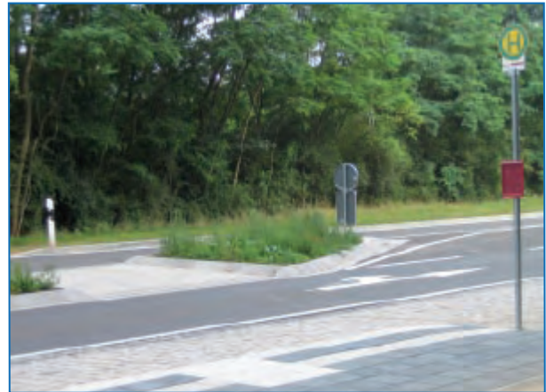
Abbildung 113: Durch Mittelinsel als Querungshilfe verbesserter Zugang zu einer außerorts neu angelegten Bushaltestelle; die Mittelinsel ist ausreichend dimensioniert und mit 3-cm-Bord abgesenkt, der Zugang zur Haltestelle erfolgt über Anrampungen (Landkreis Kaiserslautern)
