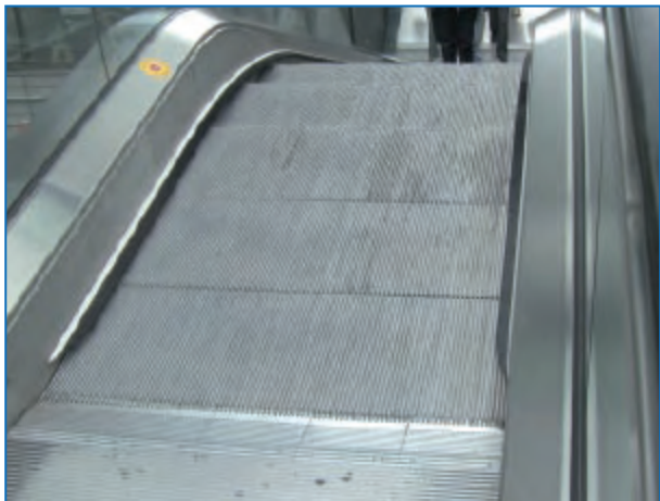
Abbildung 3: Fahrtreppe mit einem Vorlauf von drei Stufen (aber ohne die geforderten Markierungselemente, s. u.)
