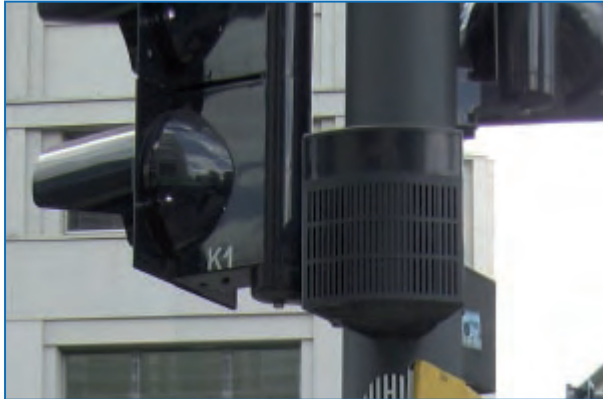
Abbildung 66: Akustischer Signalgeber, der das Auffindesignal abstrahlt
