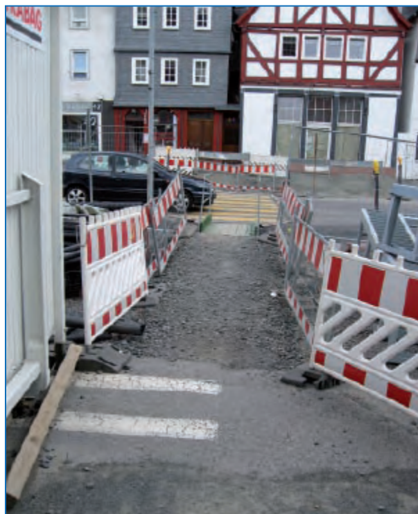
Abbildung 94: Absperrschranken aus verschiedenen Materialien mit Tastleisten an einer Großbaustelle (Marburg)
