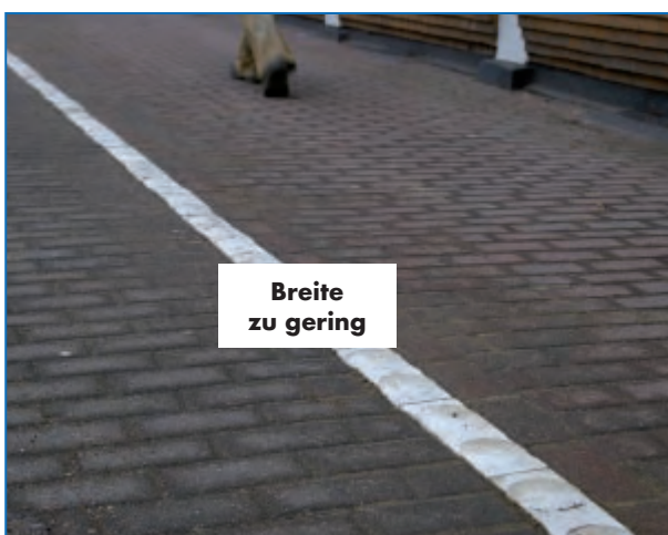
Abbildung 30, Abbildung 31: Begrenzungsstreifen bei einem getrennten Geh- und Radweg; bei der oberen Abbildung sind taktiler wie visueller Kontrast jedoch zu gering und der Pfosten ungünstig; bei der unteren Abbildung ist der visuelle Kontrast gut, die erforderliche Breite jedoch zu gering 60
