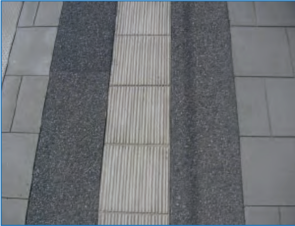
Abbildung 4: Bodenindikatoren mit Rillenstruktur 5
