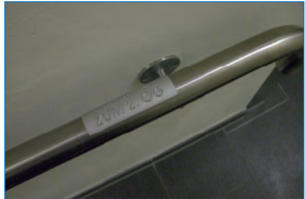
Abbildung 7: Handlauf in gut greifbarer runder Form, im Abstand zur Wand angebracht und mit Beschriftung zur Zielorientierung am Handlauf in erhabener und in Braille-Schrift
