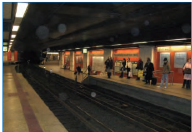
Abbildung 143: Bahnsteig mit unterschiedlichen Höhen für verschiedene Systeme bzw. Fahrzeuge (Stuttgart)
