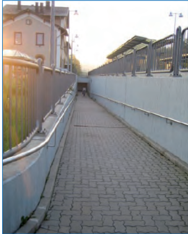
Abbildung 126: Offen gestaltete Unterführung mit Zugang über Rampe mit Radabweiser und durchgehendem Handlauf an einem regionalen Bahnhofspunkt; Treppen und Aufzüge am Gleiszugang sind vorhanden, aber in der Abbildung nicht sichtbar
