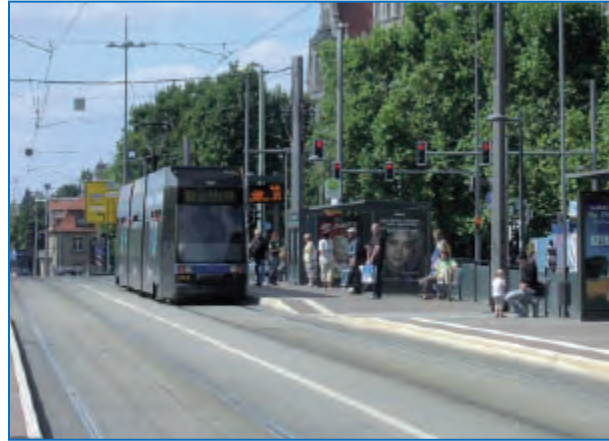
Abbildung 141: Barrierefreie gemeinsame Bus- und Straßenbahnhaltestelle (Leipzig) 367
