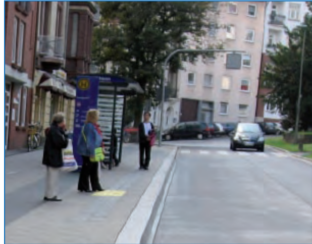
Abbildung 112: Durch Fußgängerüberweg (FGÜ) gesicherter Zugang zu einer Fahrbahnrand-Haltestelle – der Gehweg ist zugleich Zugang zur Haltestelle (Kassel)
