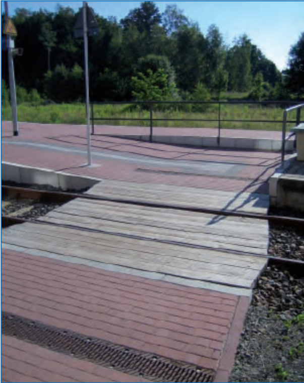
Abbildung 124: Kontrastreich gestalteter Reisendenübergang zu einem Mittelbahnsteig mit Anrampung und Blindenleitsystem (BLS) im Bahnsteigzugang
