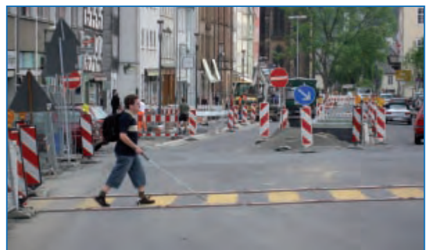
Abbildung 93: Baustellensicherung mit Signalstreifen (Marburg)
