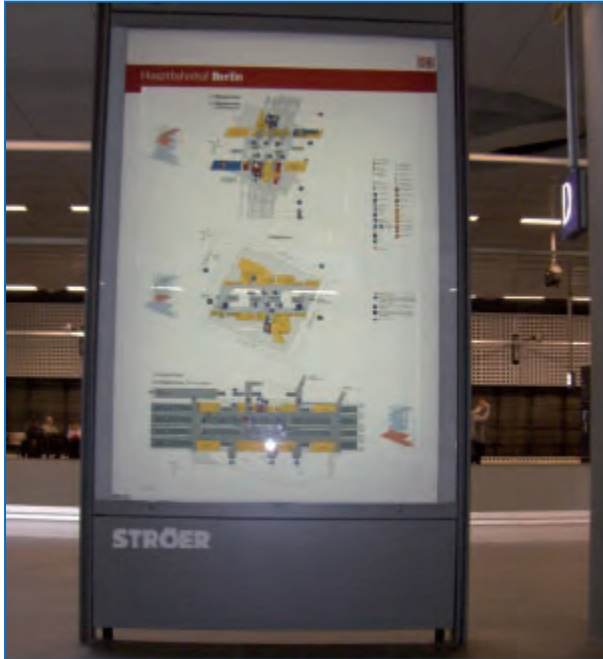
Abbildung 10: Ausstattungselement, das max. 10 cm über dem Fußboden endet (Berlin Hbf)
