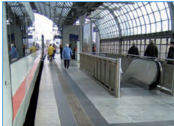
Abbildung 148, Abbildung 149, Abbildung 150, Abbildung 151: Unterschiedliche Ausführungen von Leit- und Begleitstreifen an Bahnsteigen. Oben ist die unterschiedliche Helligkeit/Kontrast bei verschiedenen Witterungsverhältnissen (nass/trocken) gut erkennbar. Die Abbildung unten rechts zeigt den Verlust des Kontrastes bei starker Verschmutzung (hier des Leitstreifens)
