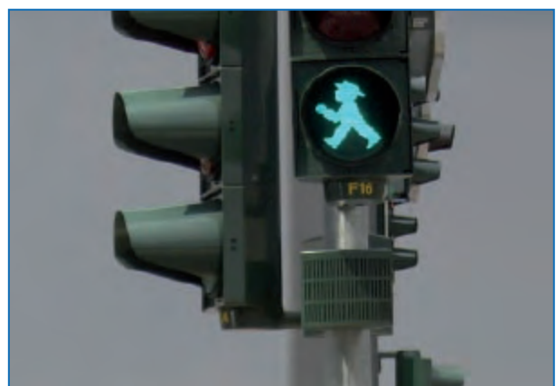
Abbildung 69: Akustischer Signalgeber, der das Freigabesignal abstrahlt
