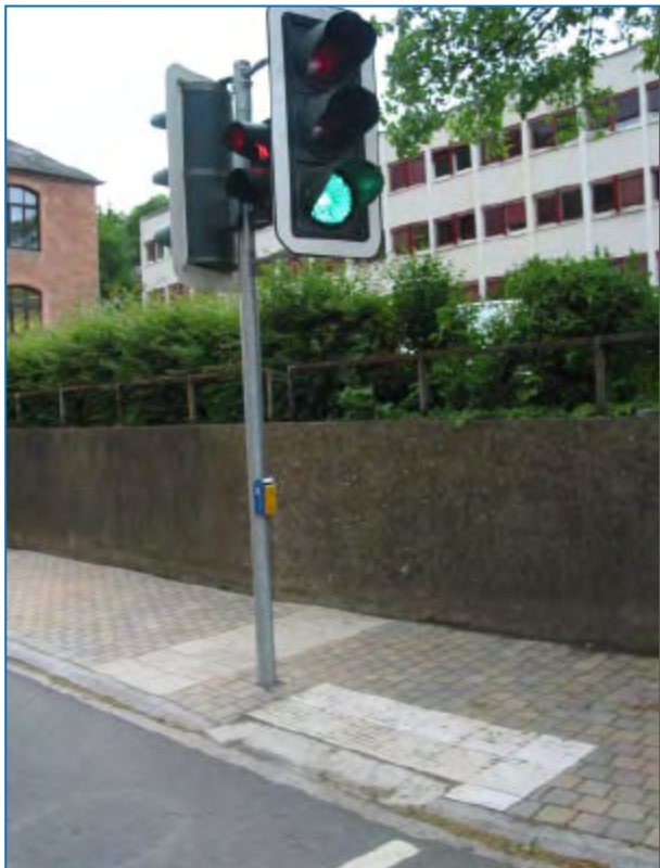
Abbildung 57: Getrennte und gleichzeitig gesicherte Querung (Marburg) 118
