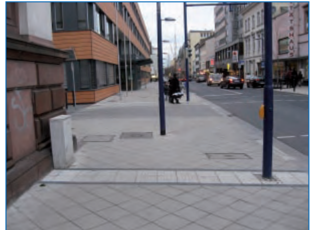
Abbildung 45: Durch Materialwechsel gekennzeichnete Gehwegüberfahrt einer Erschließungsstraße, das Gehwegniveau bleibt erhalten
