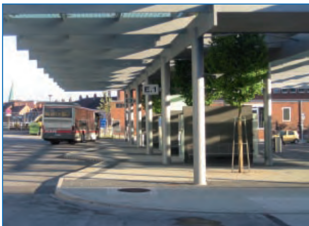
Abbildung 110: ZOB mit Mittelinsel sowie elektronischer dynamischer Anzeige. An barrierefreien Elementen wurden erhöhte Borde sowie ein Blindenleitsystem eingebaut (Kaiserslautern)
