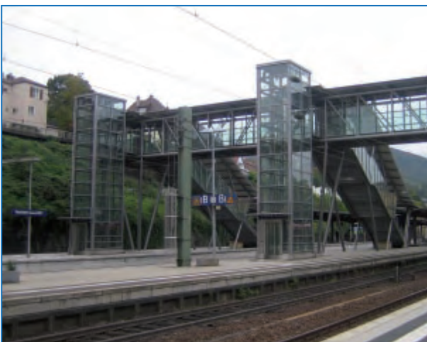
Abbildung 125: Anlagen zur Überwindung von Höhenunterschieden in Bahnhöfen – Überführung mit Treppen und transparentem Aufzug
