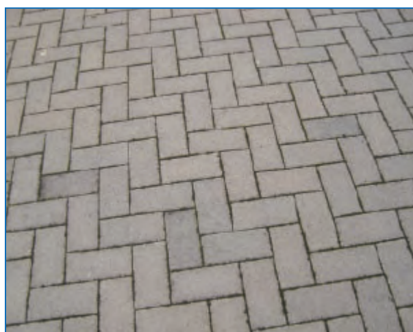
Abbildung 11: Leicht befahrbares Pflaster aus Betonwerkstein (Betonverbundsteinpflaster) mit guter Eigenrauigkeit und ohne Fasen, Fugenbreite zwischen 3 mm bis 5 mm
