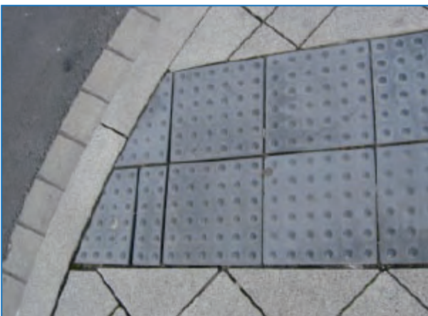
Abbildung 5: Bodenindikatoren mit Noppenstruktur 6
