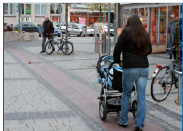
Abbildung 39, Abbildung 40: Fußgängerzone mit Muldenrinne, die auch der Orientierung dient und von Personen mit Rollstuhl, Kinderwagen oder Rollator erschütterungsarm befahren werden kann (Kaiserslautern)
