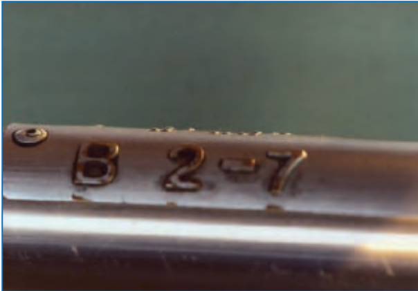
Abbildung 163: Taktile Information an Handläufen im Bahnhof (Graz)
