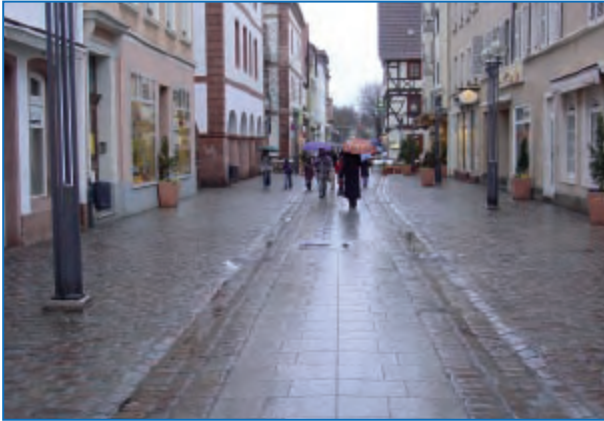
Abbildung 41: Fußgängerzone in historischem Stadtkern und mittig verlaufendem Großpflaster; Vorteil ist hier, dass die Lauflinie oberhalb der beiden Entwässerungsmulden verläuft (Landau)
