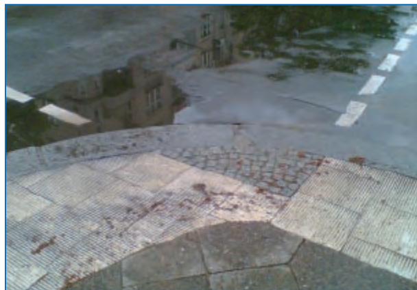
Abbildung 65: Aufmerksamkeitsfelder in unmittelbarem Anschluss an den Bord und Ausrichtung der Rillen in Querungsrichtung 149
