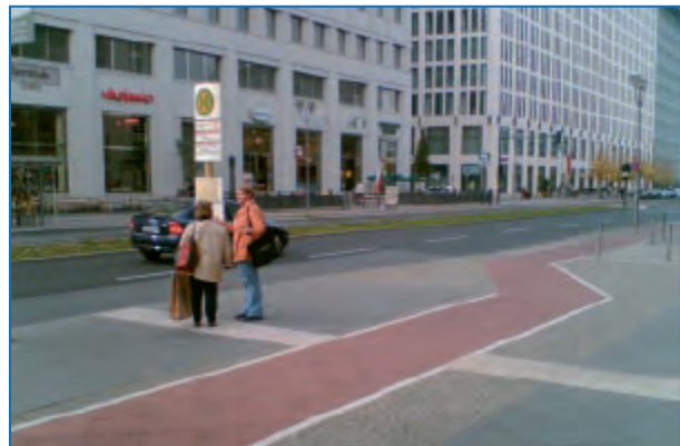
Abbildung 32, Abbildung 33: Begrenzungsstreifen bei getrenntem Geh- und Radweg; taktiler wie optischer Kontrast sind gut; der Leitstreifen zur Haltestelle ist am Radweg unterbrochen 61
