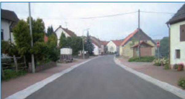
Abbildung 7, Abbildung 8: Umsetzung der weichen Trennung in ländlichen Ortsdurchfahrten; Fahrgasse und Seitenräume sind optisch und taktil zu erkennen, der Übergang zur Fahrbahn könnte taktil noch deutlicher erfassbar gestaltet sein (Sipperfeld, Konken)
