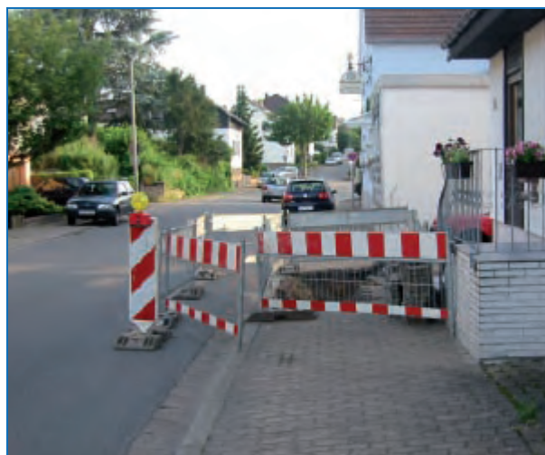
Abbildung 95: Notweg und Absperrschranken an einer kleinen Baustelle (Wadgassen)
