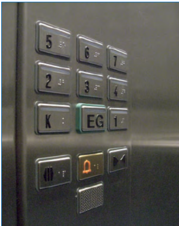
Abbildung 7: Aufzugtastatur mit erhabenen Zeichen und Braille-Schrift.
