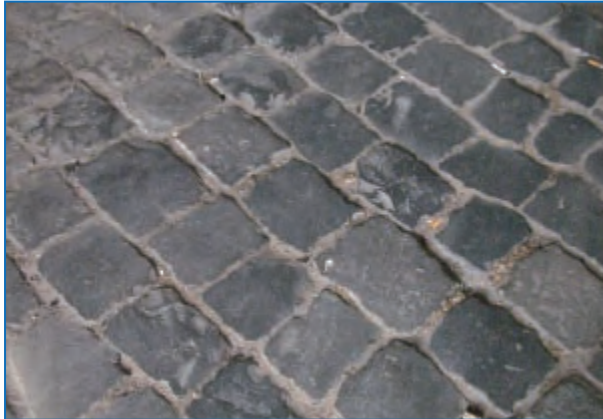
Abbildung 10: Ungeeignetes, unebenes Natursteingroßpflaster (Basalt) mit Fugen bis zu 40 mm, nur mit großer Mühe befahrbar und insbesondere bei Nässe glatt
