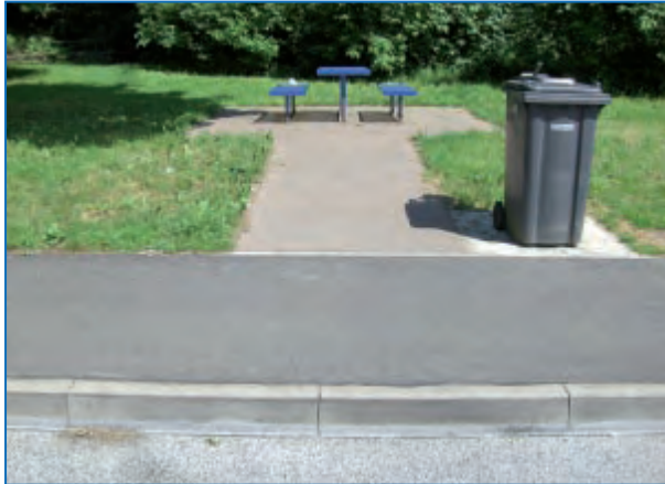
Abbildung 104: Kein barrierefreier Zugang! Rastplatz an der Autobahn 45
