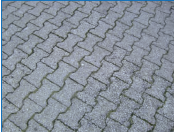
Abbildung 15: Mit Abstandhaltern verlegtes Betonverbundsteinpflaster (Fugenbreite 3 mm bis 8 mm)
