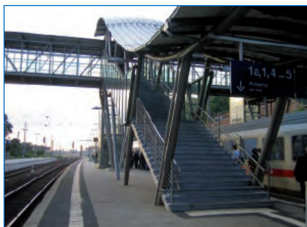
Abbildung 129: Überführung mit Zugang über Treppen und Aufzüge (Neustadt/Wstr.)
