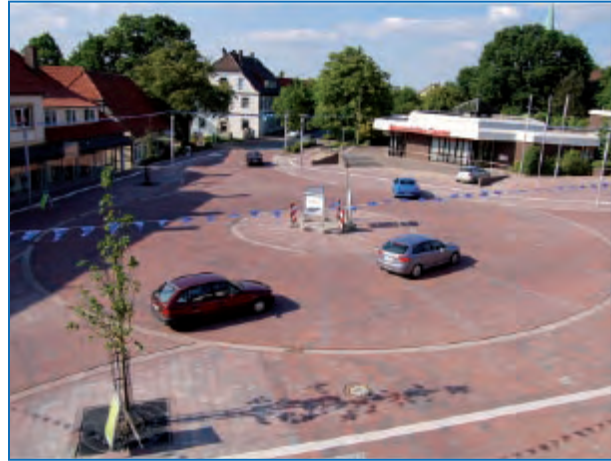
Abbildung 4: Im Rahmen von „Shared Space“ umgestalteter Dorfplatz (Bohmte) 11
