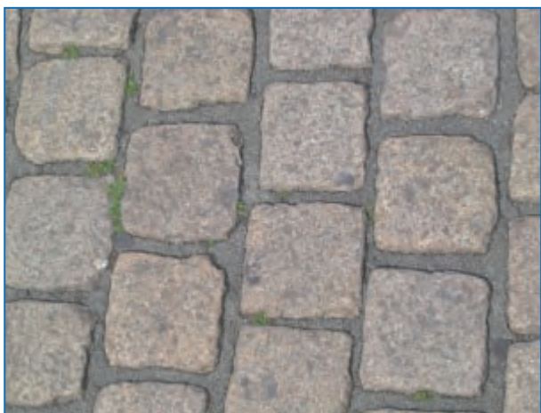
Abbildung 13: Natursteinpflaster (Granit) mit guter Rauigkeit, aber nur schwer befahrbar wegen breiter Fugen von bis zu 20 mm
