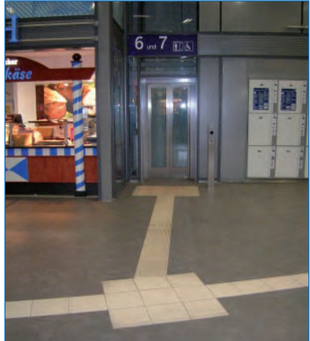
Abbildung 128: Deutliche Hinführung zum Aufzug (Hauptbahnhof Gelsenkirchen)
