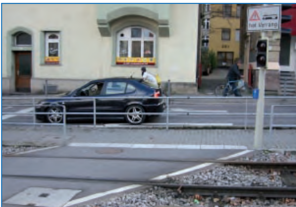
Abbildung 116: Z-förmige Bahnkörper-Querungsstelle mit Aufmerksamkeitsfeld und Markierung (das AMF müsste nach DIN 32984 mit Rillen in Gehrichtung ausgeführt sein) (Stuttgart)
