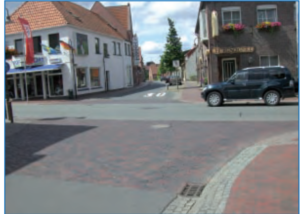
Abbildung 47: (erschütterungsarme) aufgepflasterte Querungsstelle (Friesoythe)
