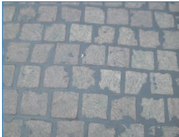
Abbildung 14: Natursteinpflaster (Granit) mit dauerelastischem (bituminösen) Fugenverguss, der eine leichte Befahrbarkeit gewährleistet 26
