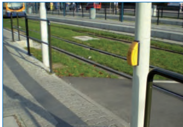
Abbildung 117: Blindenleitsystem zu einer signalgesicherten Z-förmigen Bahnkörper-Querungsstelle (das AMF müsste nach DIN 32984 mit Rillen in Gehrichtung ausgeführt sein) (Mannheim) 316
