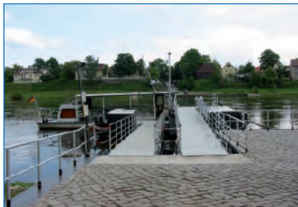
Abbildung 169, Abbildung 170: Barrierefreie Nutzung einer Anlegestelle mit hohem bzw. niedrigem Einstieg für Ausflugsschiffe bzw. für die Elbfähre 420 ; die Pflasterung vor der Anlegestelle ist jedoch nicht erschütterungsarm; auch fehlen Tastkanten zur Orientierung (Anlegestelle Heidenau)
