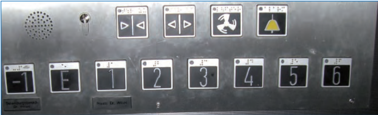
Abbildung 2: Extragroße Befehlsgeber in einem Aufzug (hier mit erhabener und Braille-Schrift)
