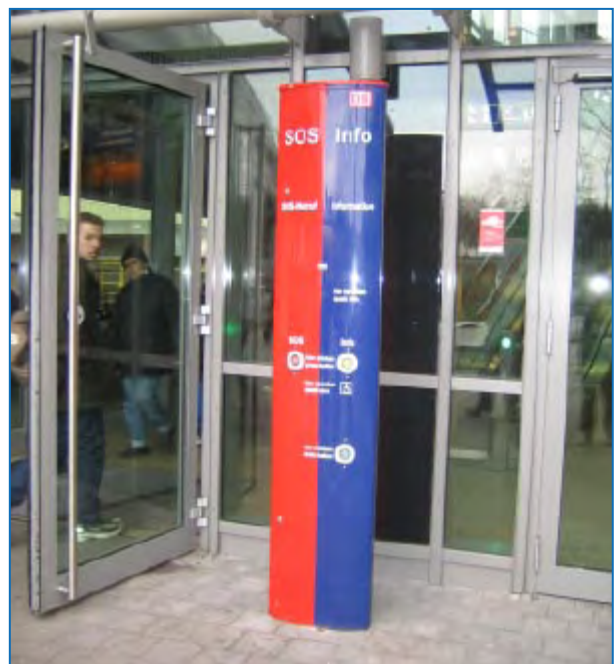
Abbildung 168: Informations- und Notrufsäule an einem Hauptbahnhof
