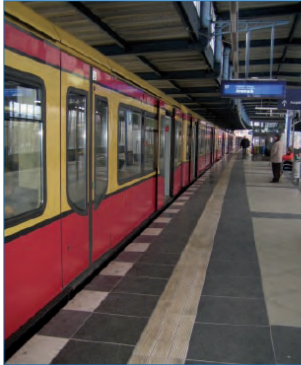
Abbildung 144: S-Bahnsteig mit geringem Höhenunterschied und Spaltbreite in Berlin; zusätzlich verfügt die Berliner S-Bahn über manuelle Rampen aus Blech
