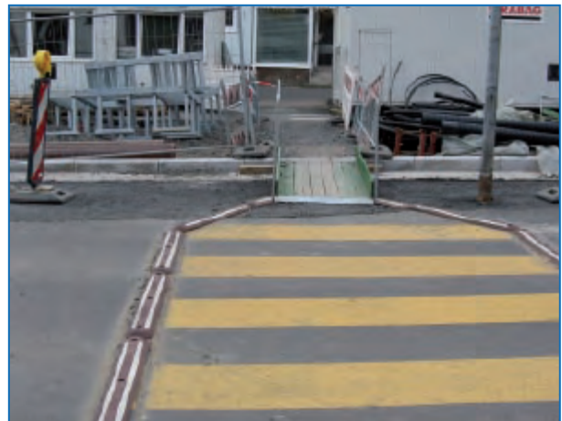
Abbildung 92: Baustellensicherung mit Überweg und Führungstreifen (Marburg)
