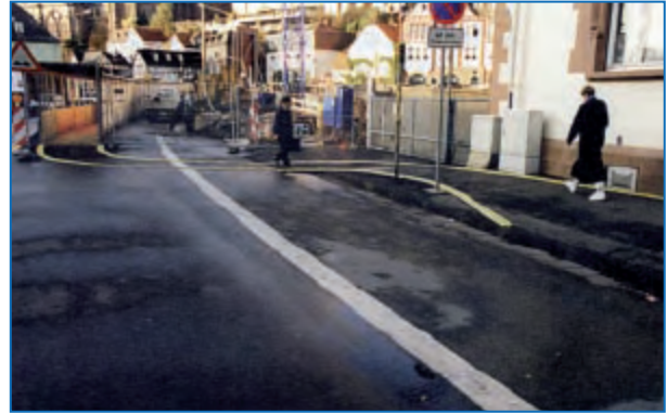
Abbildung 91: Führungstreifen im Ein- und Ausgangsbereich einer Baustelle 227
